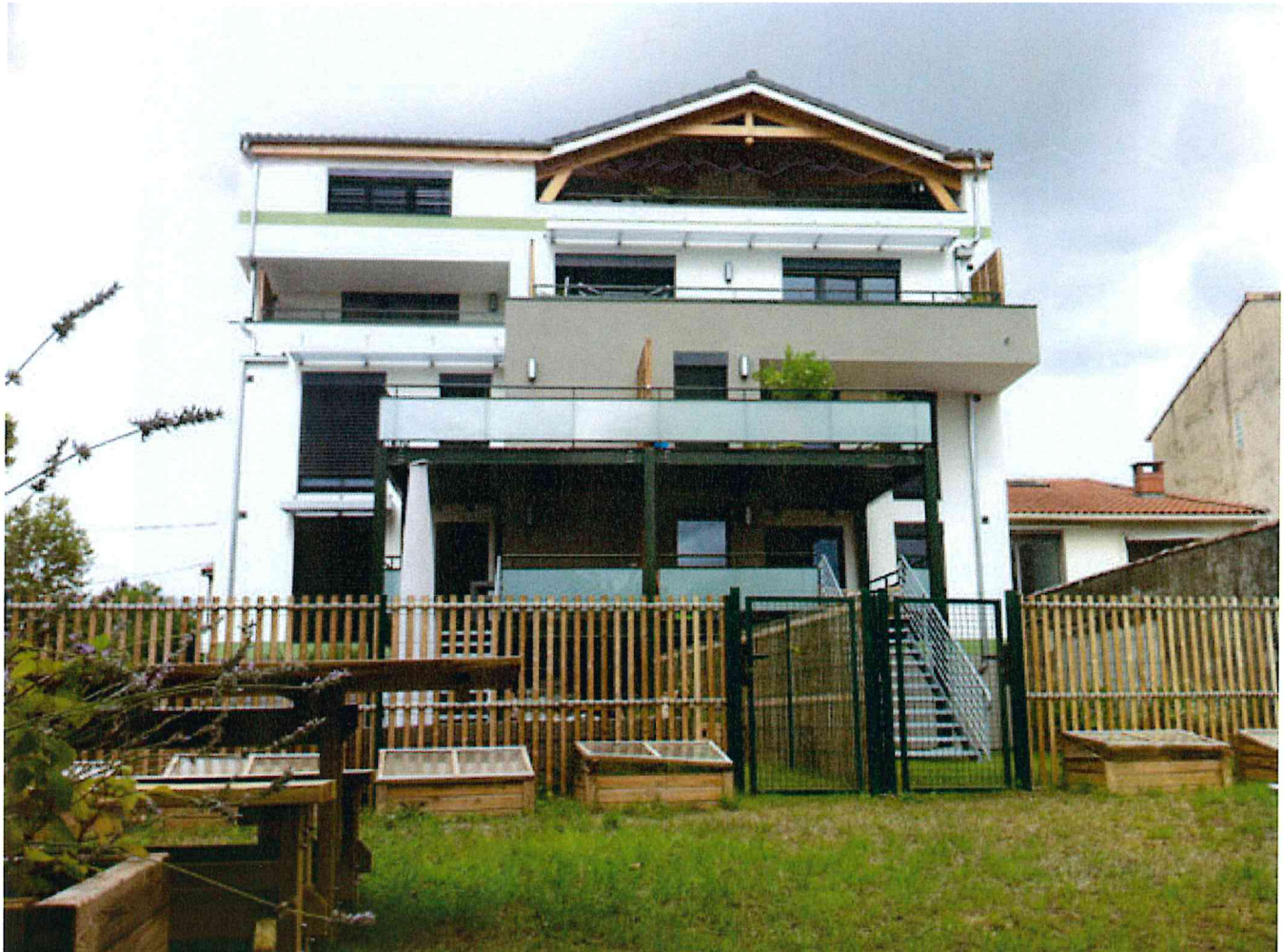
La résidence passive comprend sept logements et 14 habitants. (Photo : Les Architecteurs)
